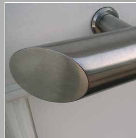
Detail Griff maßgefertigte Edelstahl-Querstangen, schräg auslaufend
